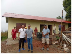
मझवाड मा.वि भवन निर्माण ११
